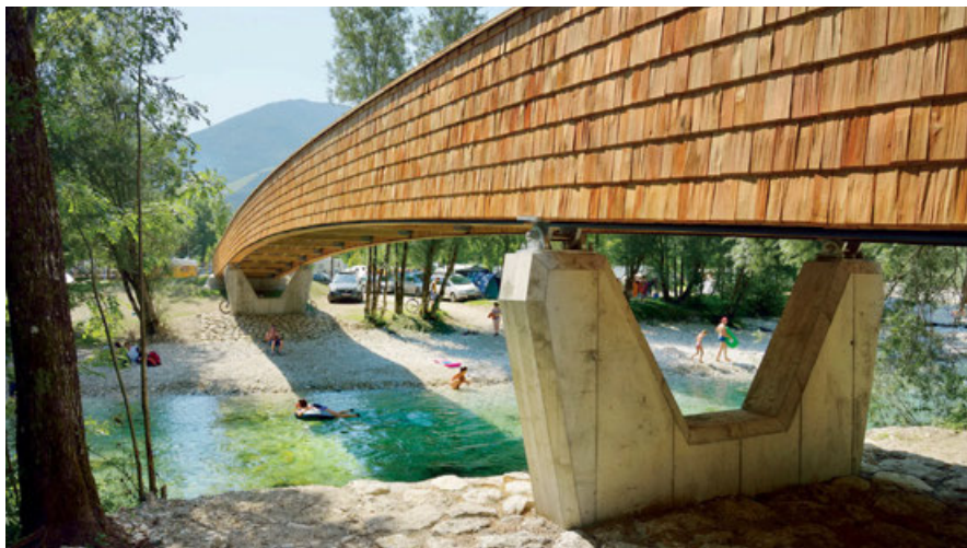
Nagrajeno kolesarsko brv je zasnovala avtorska skupina Dans arhitekti. / Foto: Miran Kambič
