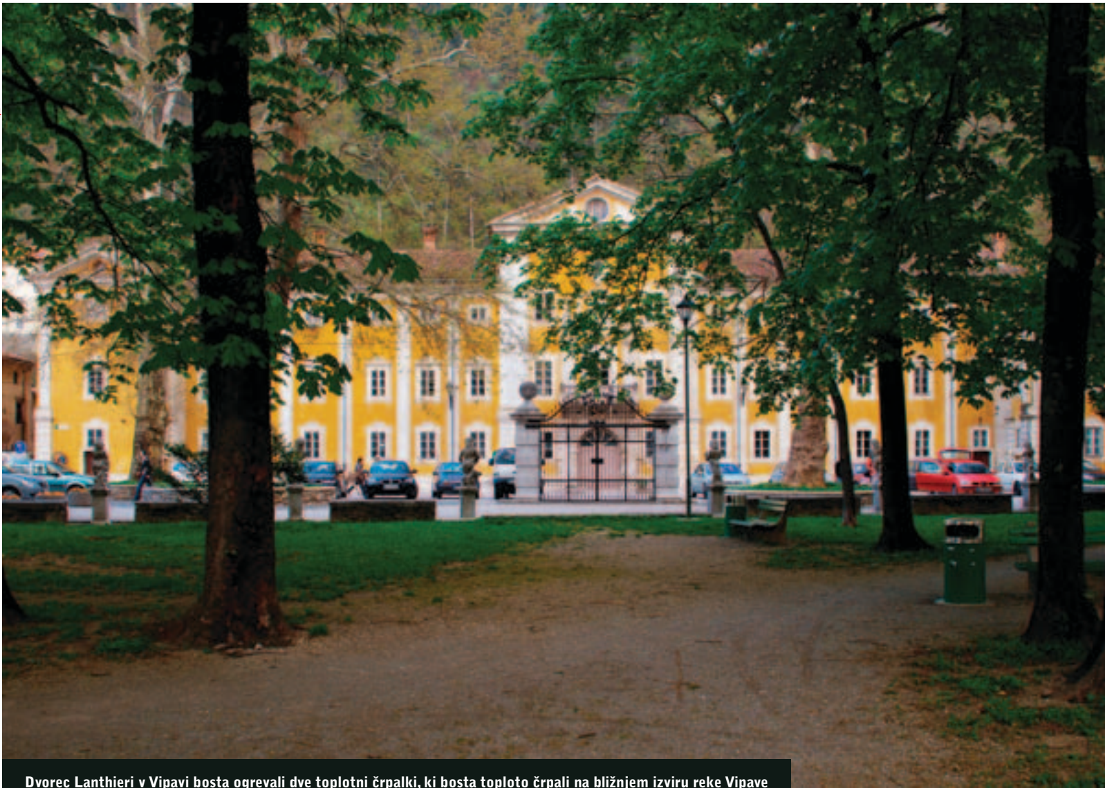
Dvorec Lanthieri v Vipavi bosta ogrevali dve toplotni črpalčki, ki bosta toploto črpali na bližnjem izviro reke Vipave
