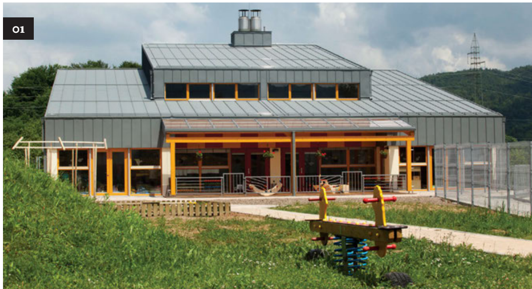
Novi montažni leseni pasivni vrtec v Moravčah skoraj ne potrebuje zunanje energije, saj je dejansko skoraj ničenergijska stavba. / Foto: Borut Krajnc
